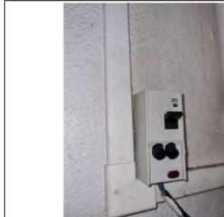
Libellé de l'anomalie : B8.3 e Au moins un conducteur isolé n'est pas placé sur toute sa longueur dans un conduit, une goulotte ou une plinthe ou une huisserie, en matière isolante ou métallique, jusqu'à sa pénétration dans le matériel électrique qu'il alimente.
