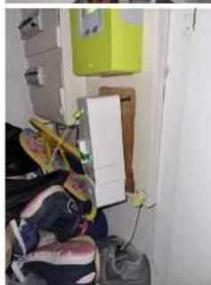
Libellé de l'anomalie : B5.3 a Locaux contenant une baignoire ou une douche : la continuité électrique de la liaison équipotentielle supplémentaire, reliant les éléments conducteurs et les masses des matériaux électriques, n'est pas satisfaisante (résistance supérieure à 2 ohms).
