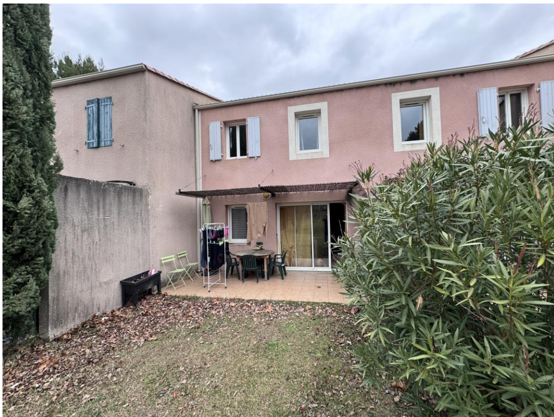
Façade côté arrière :
