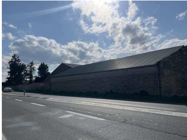
Continuité de la clôture, dans la continuité de la RD471, parpaings bruts jointoyés surmontés d'un mur en pierres jointoyées et chaperon en tuiles à deux pans
