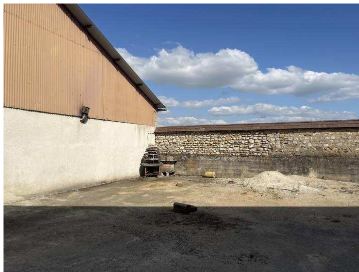
Continuité de la clôture, dans la continuité de la RD471, parpaings bruts jointoyés surmontés d'un mur en pierres jointoyées et chaperon en tuiles à deux pans
