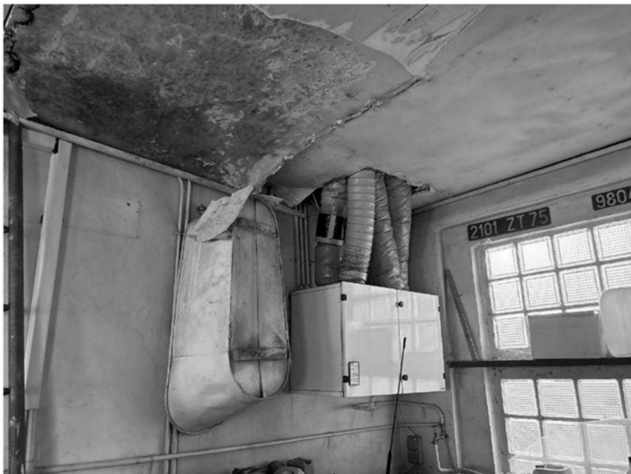
Des tuyaux de pompe à chaleur passent dans le faux plafond du garage.
