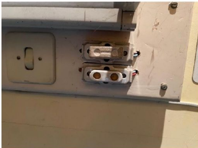
B.4.3 b) : Le type d'au moins un fusible ou un disjoncteur n'est plus autorisé (fusible à tabatière, à broches rechargeables, coupe-circuit à fusible de type industriel, disjoncteur réglable en courant protégeant des circuits terminaux).
