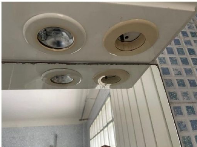
B.5.3 a) : Locaux contenant une baignoire ou une douche : la continuité électrique de la liaison équipotentielle supplémentaire, reliant les éléments conducteurs et les masses des matériels électriques, n'est pas satisfaisante (résistance supérieures à 2 ohms).
