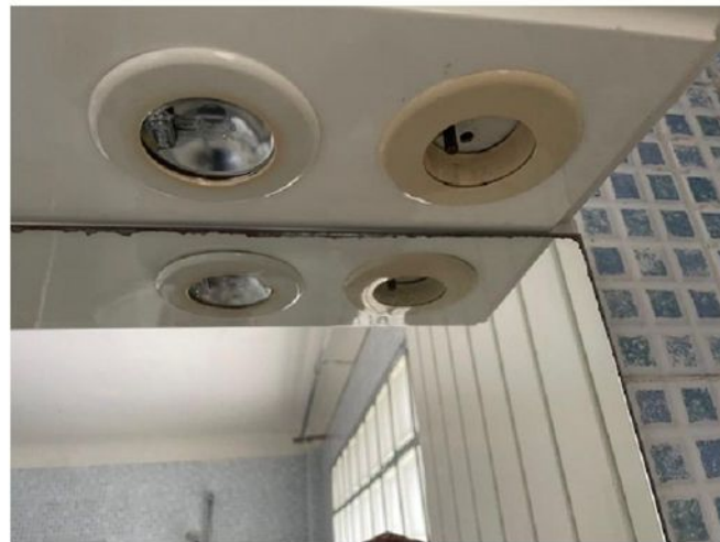
B.6.3.1 a) : Local contenant une baignoire ou une douche : l'installation électrique ne répond pas aux prescriptions particulières appliquées à ce local (adéquation entre l'emplacement où est installé le matériel électrique et les caractéristiques de ce dernier - respect des règles de protection contre les chocs électriques liées aux zones).
