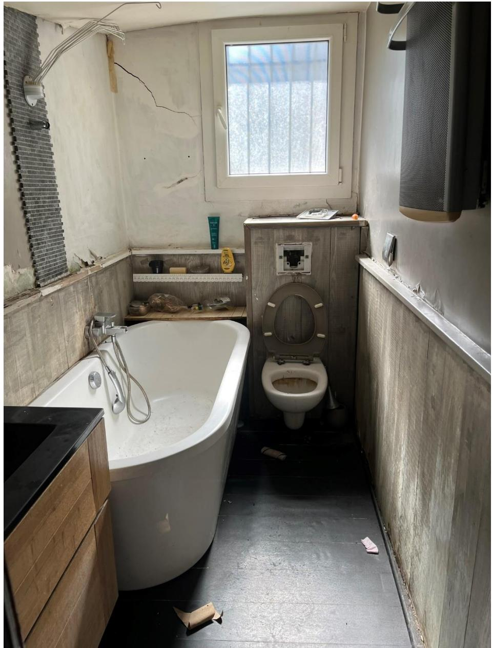
Je note la présence d'une importante fissure dans le mur à gauche de la fenêtre.
