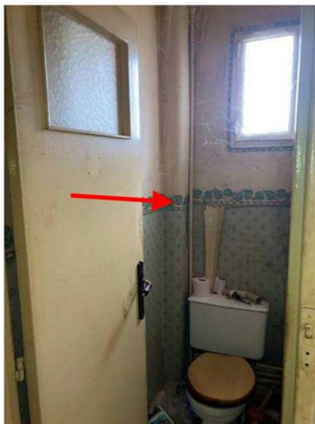
WC : Conduit de fluide en amiante-ciment
