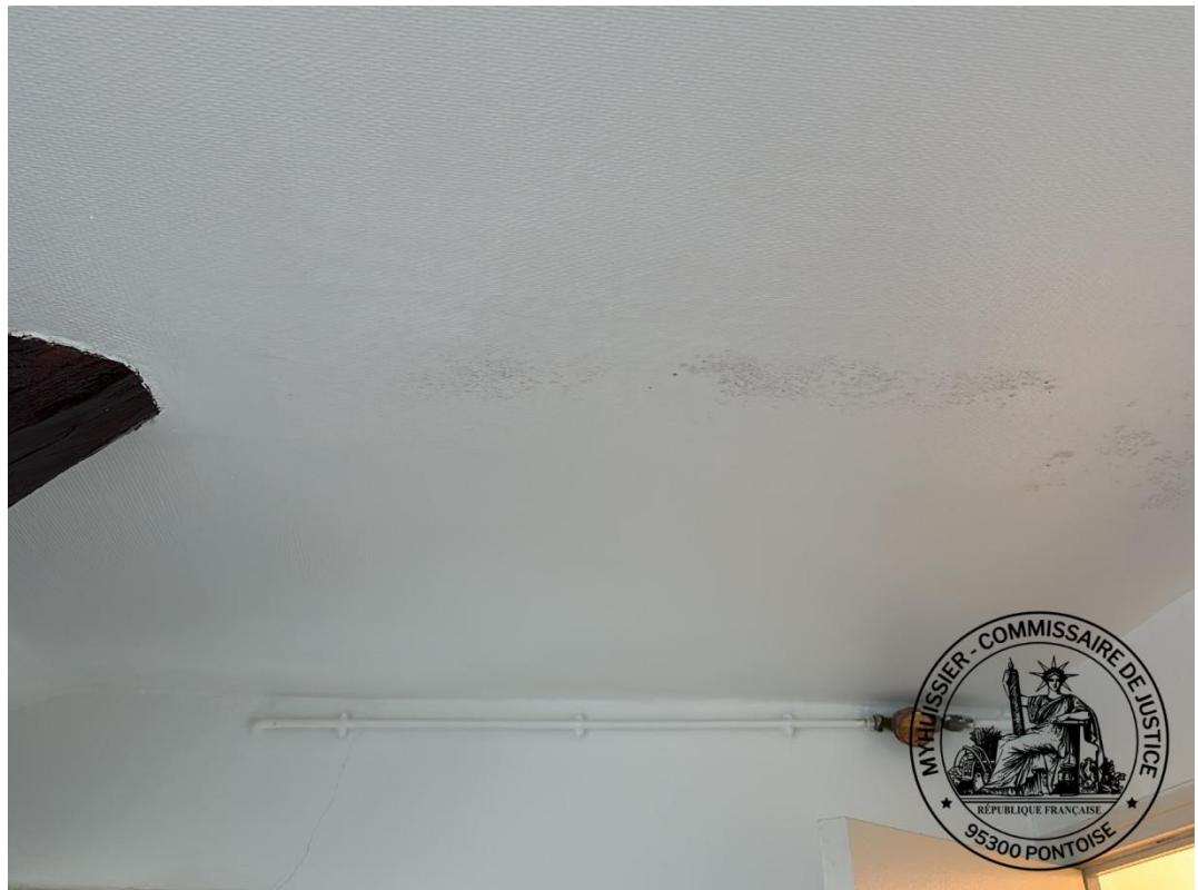
Sur les murs, présence de fibres de verre et peinture. L'ensemble est en bon état, laissant cependant apparaître des traces et marques d'humidité sous le Vélux.
