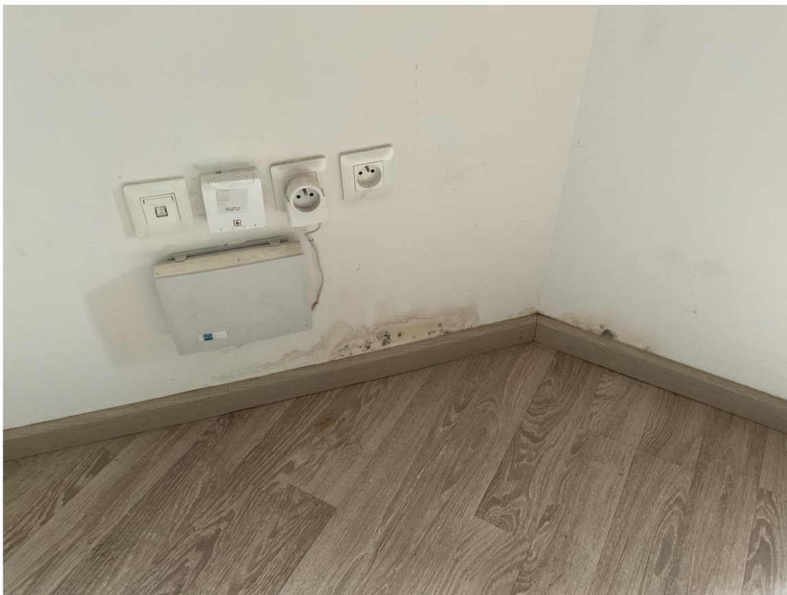
Légères traces brunâtres en partie basse du mur à gauche de la porte fenêtre coté séjour
