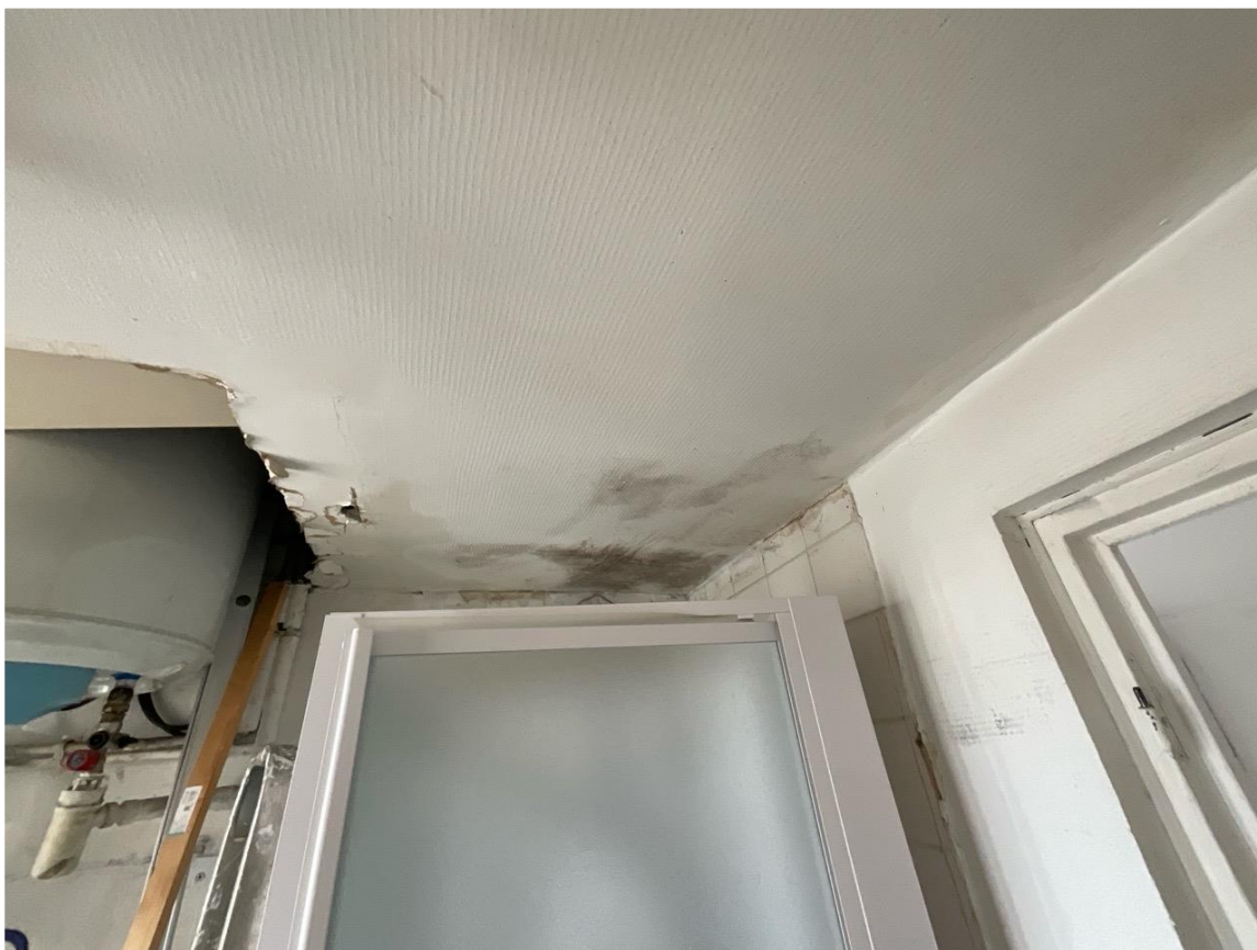
Traces noirâtres au-dessus de la cabine de douche au plafond
