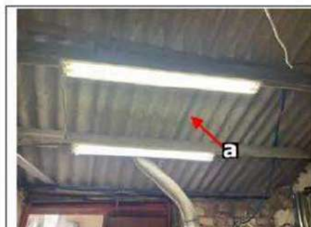
Photo n° PhA001 Localisation : Dépendance - Garage Ouvrage : 1 - Couvertures, Toitures, Terrasses et étanchéités - Plaques ondulées et planes Partie d'ouvrage : Plaques en fibres-ciment (y compris plaques « sous tuiles ») Description : Plaques en fibres-ciment (y compris plaques « sous tuiles »)
