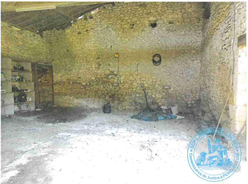
Le sol est composé d'une chape brute, les murs sont en pierres jointées, le plafond est constitué du solivage et de la toiture.
