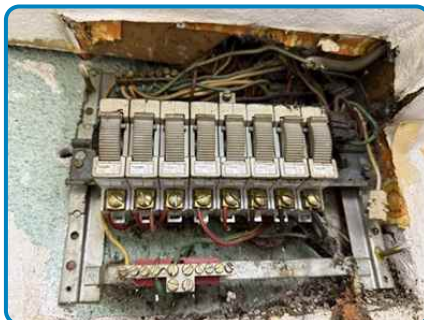
Install. n°1 App. n°1 (TRS n°1): Protection en amont non repérée Anomalie B.4.3 f3 sur Install. n°1 App. n°1 (TRS n°1)
