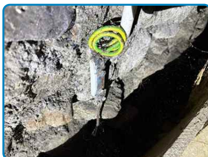
TERRE sur Install. n°1 (dans Sous sol Cave)
