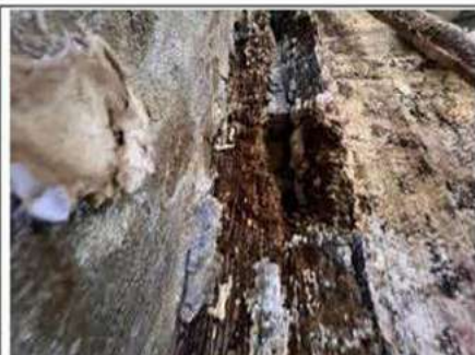
Photo n° PhTer001 Localisation : Rez ■ chaussée - escaliers Ouvrage : Poutres bois Parasite : Présence d'indices d'infestation d'autres agents ■ dégradation biologique du bois, Type non spécifié Indices : dégradation(s) importante(s), présence étendue, présence sur tout l'élément concerné Informations complémentaires : Plafond en péril
