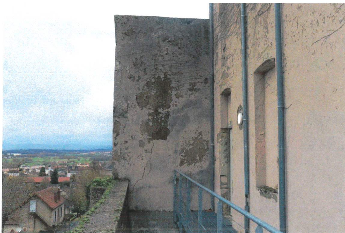
Le mur Sud est en enduit craquelé et fissuré.
