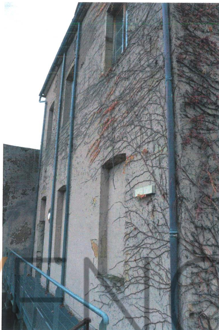
Le mur Sud est en enduit craquelé et fissuré.
