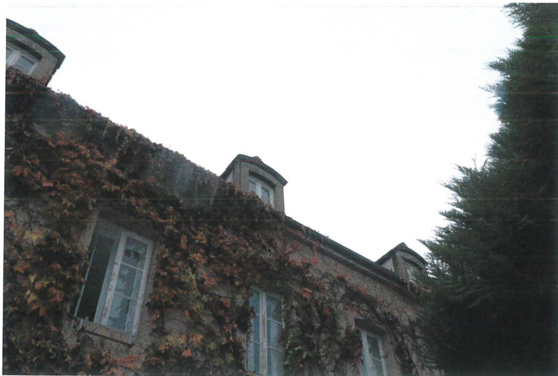
↳ Le mur Sud en enduit est envahi par la végétation.
