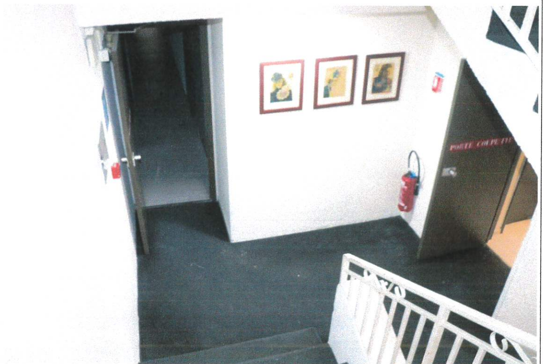
↪ Palier du premier étage : Le sol est moqueté. Les murs sont en enduit. Le plafond est en enduit avec un point lumineux. Les portes coupe – feu sont en bois.
