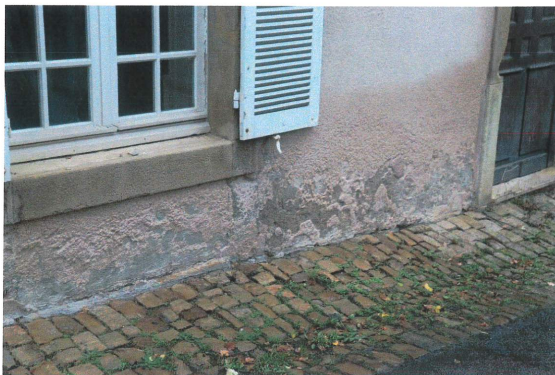
L'enduit est manquant sur la partie basse.
