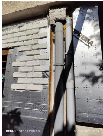
Photo PhDPE002 Ouvrage : Isolation extérieure partielle
