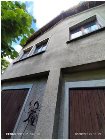
Photo PhDPE001 Ouvrage : Sud
