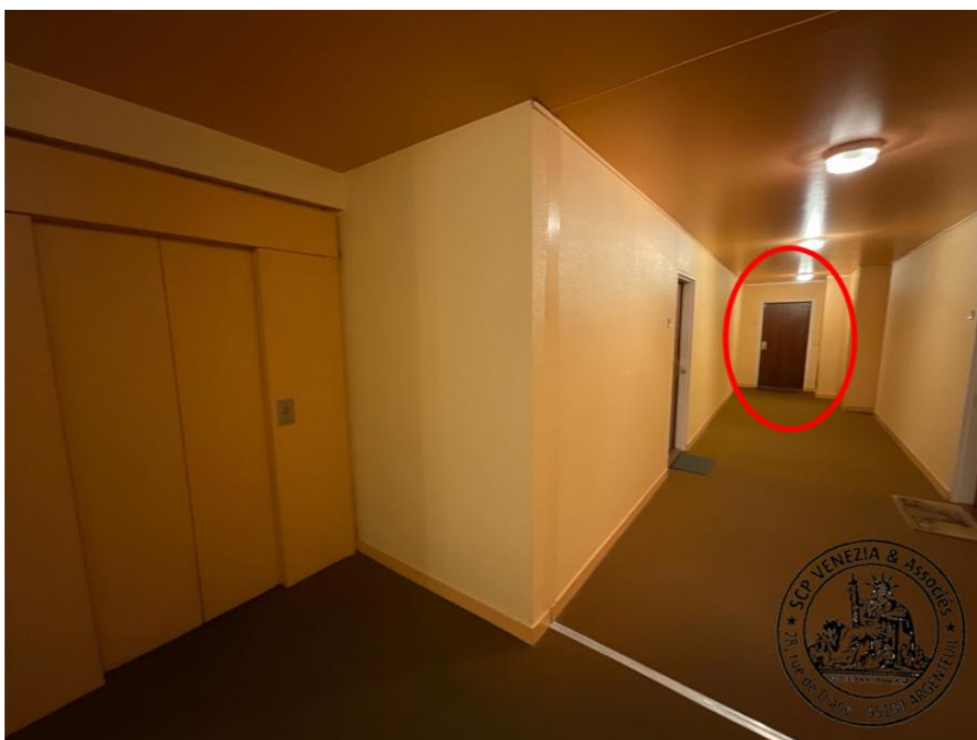
10. Palier du 3ème étage et porte palière du logement
