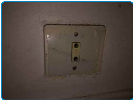
Install. n°1 : Au moins un socle de prise de courant ne possède pas un puits de 15 mm.
