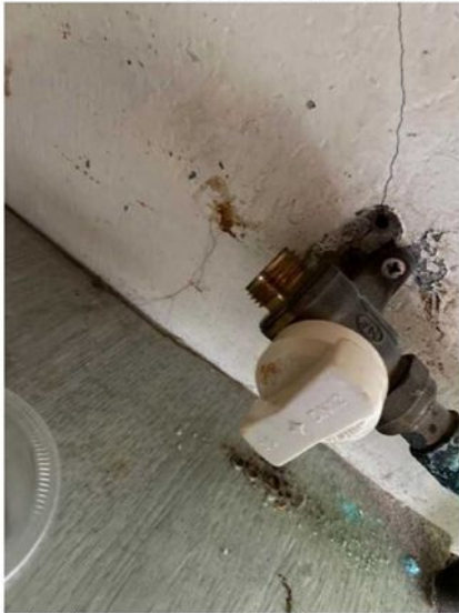
8b : L'extrémité de l'organe de coupure d'appareil ou de la tuyauterie en attente n'est pas obturée.
