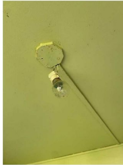
B.8.3 b) : L'installation comporte au moins un matériel électrique inadapté à l'usage.
